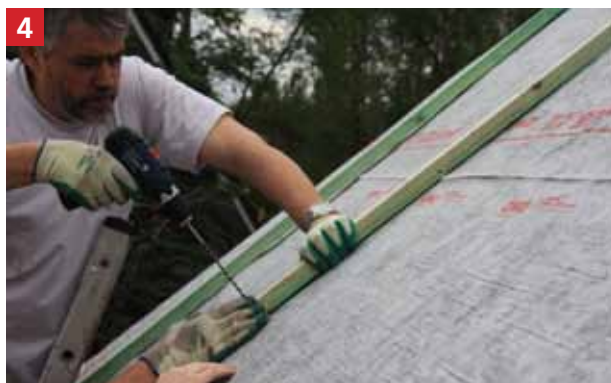
4 Připevněte kontralatě pomocí šroubů IKO FIX.
