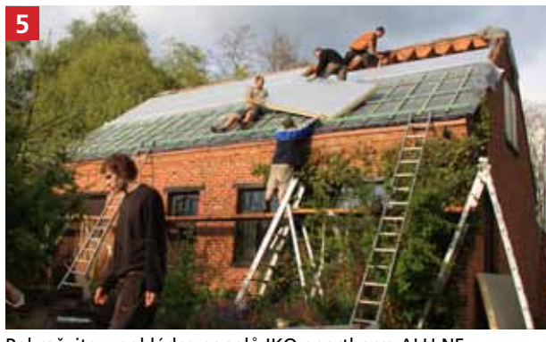
5 Pokračujte v pokládce panelů IKO enertherm ALU NF ve vrchní části střechy.
