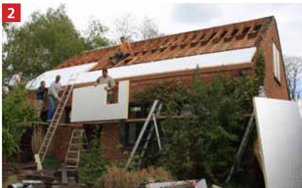
2 Pokládka panelů IKO enertherm ALU NF.
