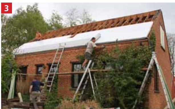
3 Položení paropropustné vodotěsné podstřešní fólie IKO stub a předvrtaných kontralatí
