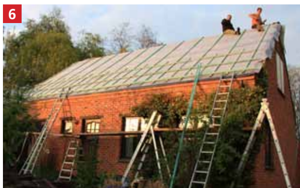
6 Položení podstřešní fólie IKO stub a kontralatí ve vrchní části střechy na desky IKO enertherm ALU NF.
