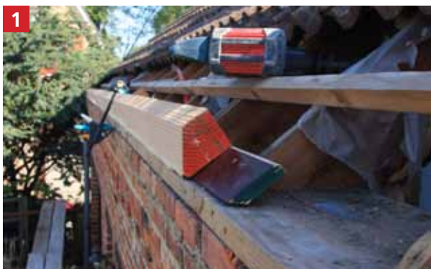
1 Upevnění podpěrného profilu.
